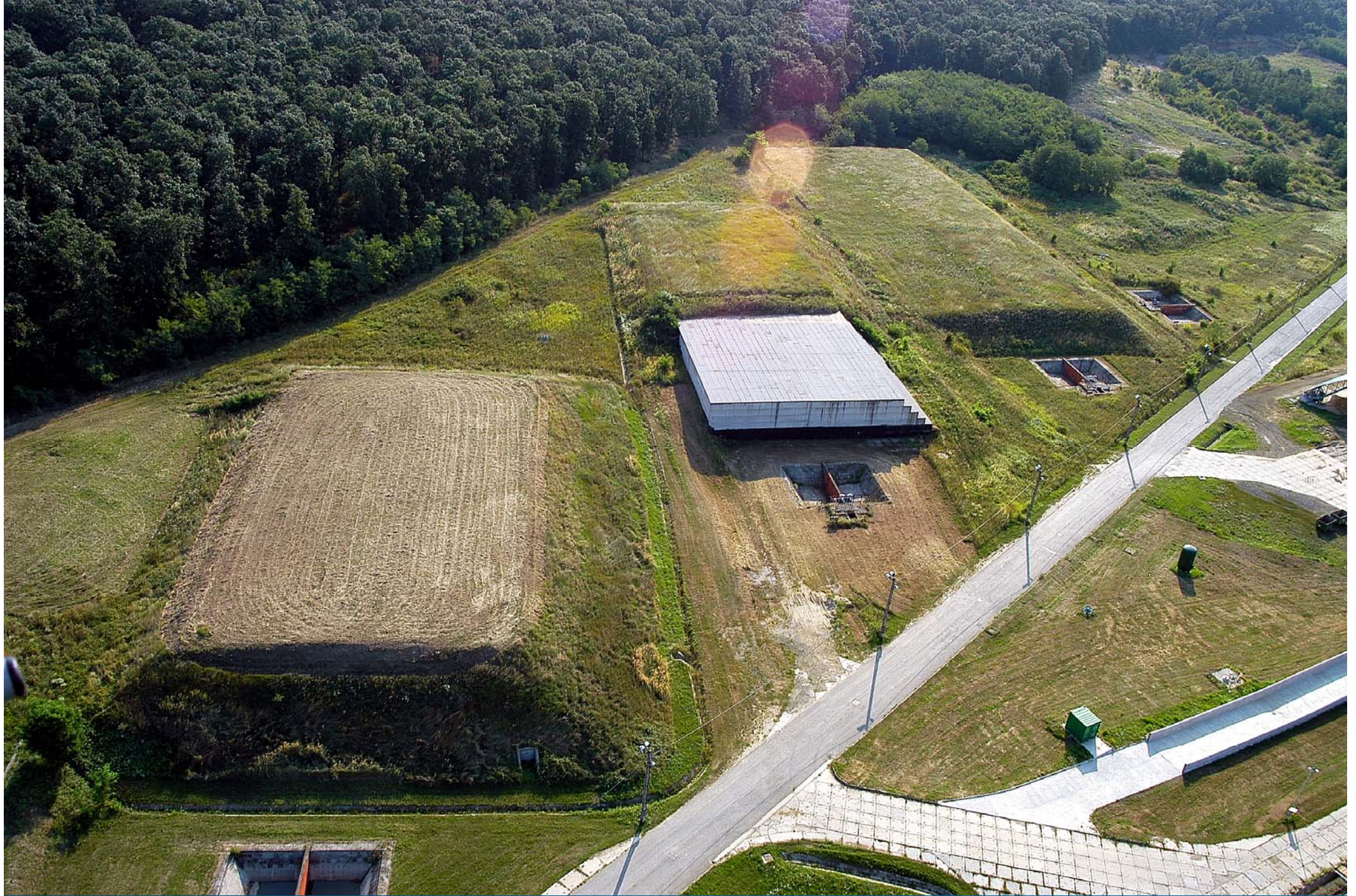
Veszélyeshulladék kazetták rekultivációt követően – Aszód-Galgamácsa
