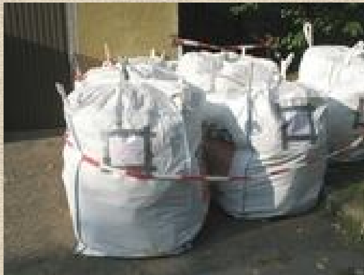
5. kép: A veszélyes hulladékként számon tartott bontott azbeszt ideiglenes tárolása
