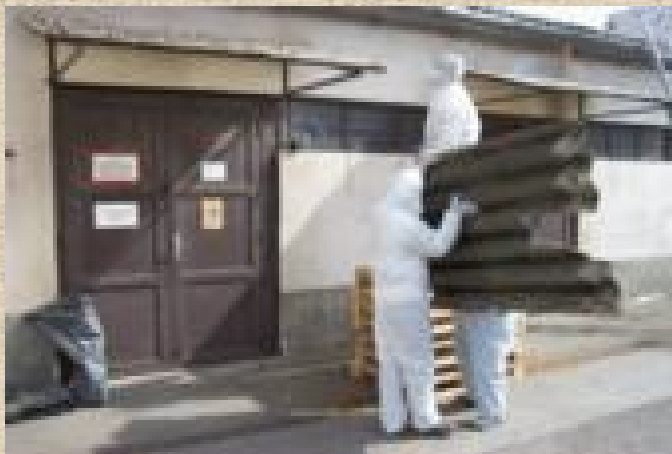
4. kép: Azbeszttartalmú pala szakszerű eltávolítása
